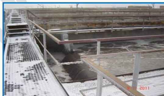
Отвод сточной воды в отстойники [42a]
