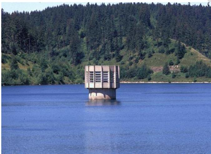
Рисунок 9. - Водозаборная плотина башенного водовыпуска [9]
