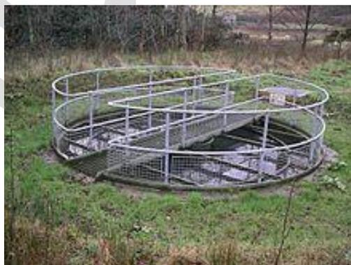
Рисунок 38. – Вторичный осветлитель на сельском очистном заводе [38]
